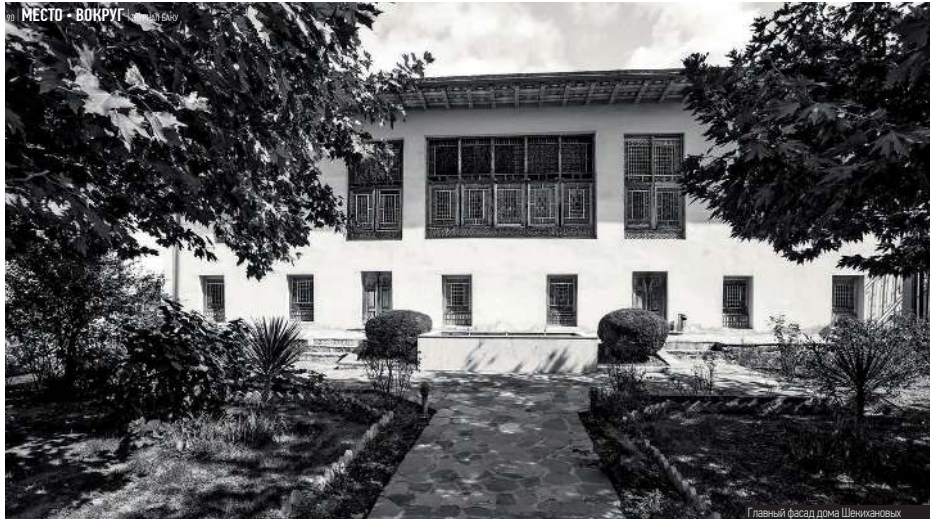
Главный фасад дома Шехихановых
